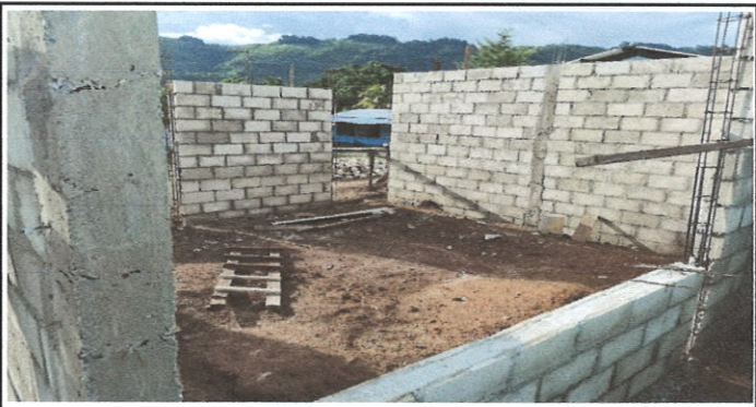
Foto 2: Mejoramiento de aula tipo portico
