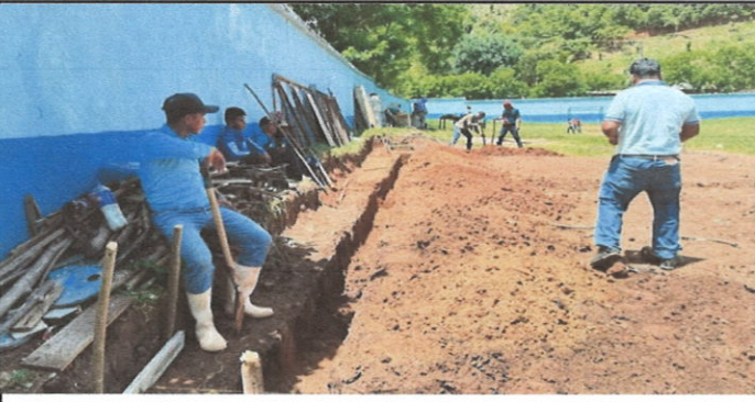
Foto 6: Mejoramiento de aula tipo portico
