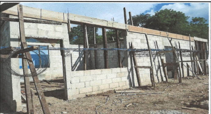
Foto 4: Mejoramiento de aula tipo portico
