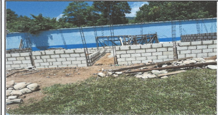
Foto 1: Mejoramiento de aula tipo portico
