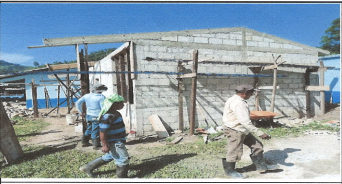
Foto 6: Mejoramiento de aula tipo portico
