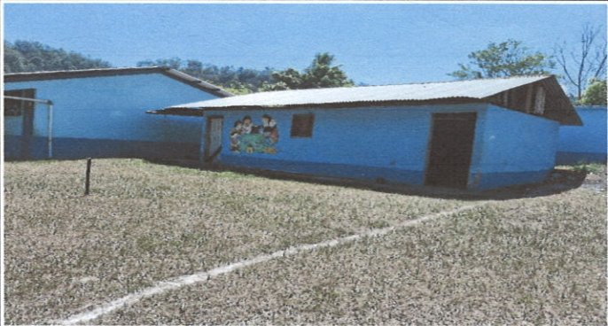
Foto 2: Mejoramiento de aula tipo portico
