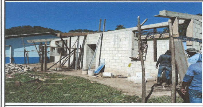
Foto 5: Mejoramiento de aula tipo portico
