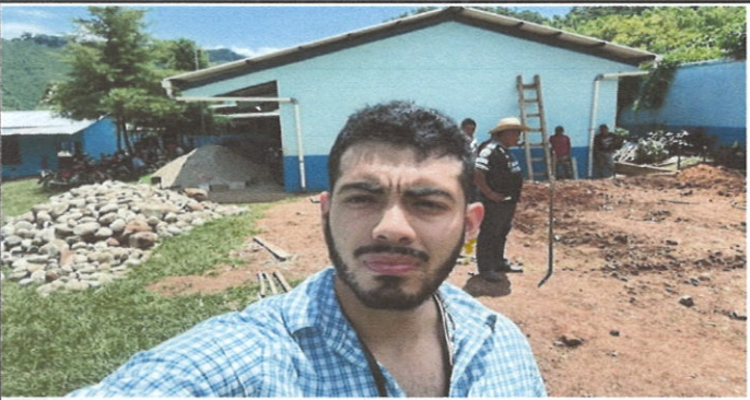
Foto 5: Mejoramiento de aula tipo portico
