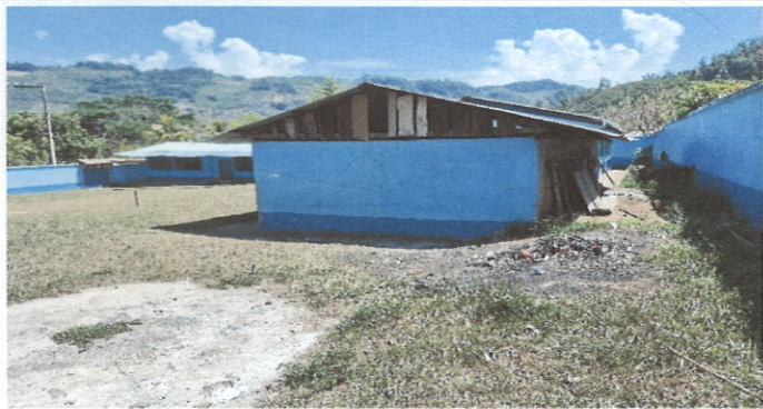
Foto 1: Mejoramiento de aula tipo portico
