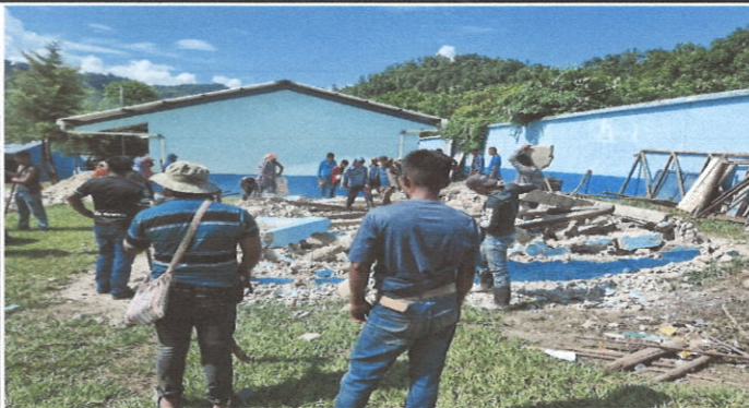
Foto 3: Mejoramiento de aula tipo portico
