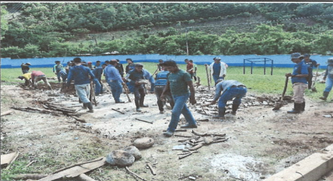
Foto 4: Mejoramiento de aula tipo portico
