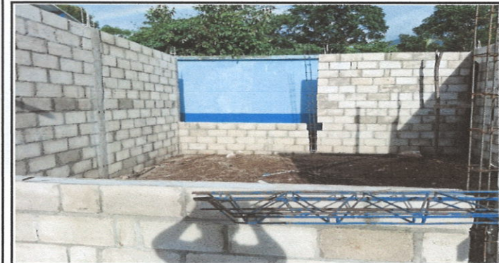
Foto 3: Mejoramiento de aula tipo portico
